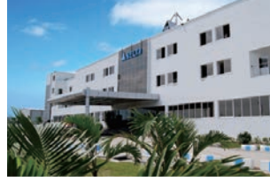
Rudrapur Fabrika (Yeşil Bina)
