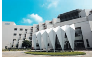
Tainan Fabrika (Elmas Sınıfı Yeşil Bina)
